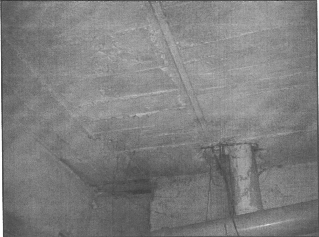
RESİM.1. 5823 ADA 1 PARSEL İÇERİSİNDE YER ALAN YAPILARIN DURUMU
