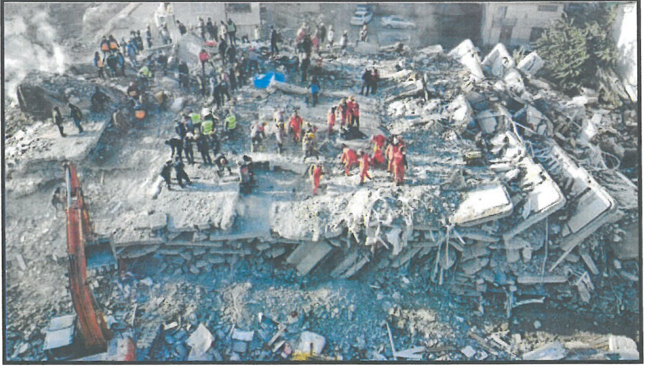
Şekil 9. 6 Şubat 2023 Kahramanmaraş Depremi Sonucu Enkaza Dönmüş Binalar.
