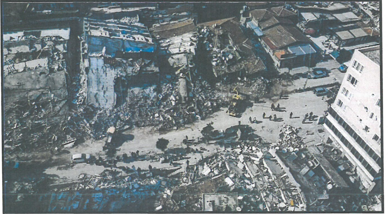
Şekil 10. 6 Şubat 2023 Kahramanmaraş Depremi Sonucu Enkaza Dönmüş Binalar.
